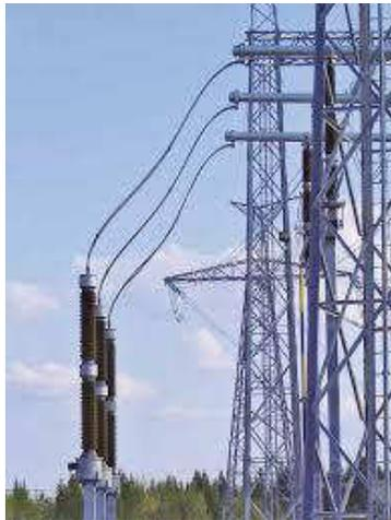
Para aplicación de media tensión se podrá usar transformadores de tensión del tipo inductivos; pero en alta y muy alta tensión se usarán transformadores de tensión capacitivos.
